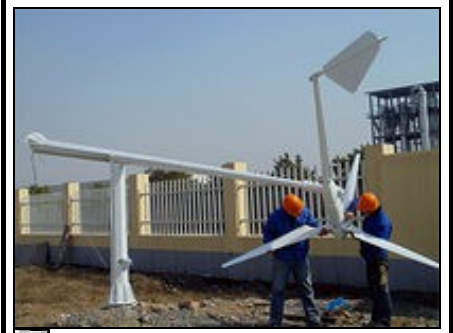
Fig 8(d) Tiltup tower
